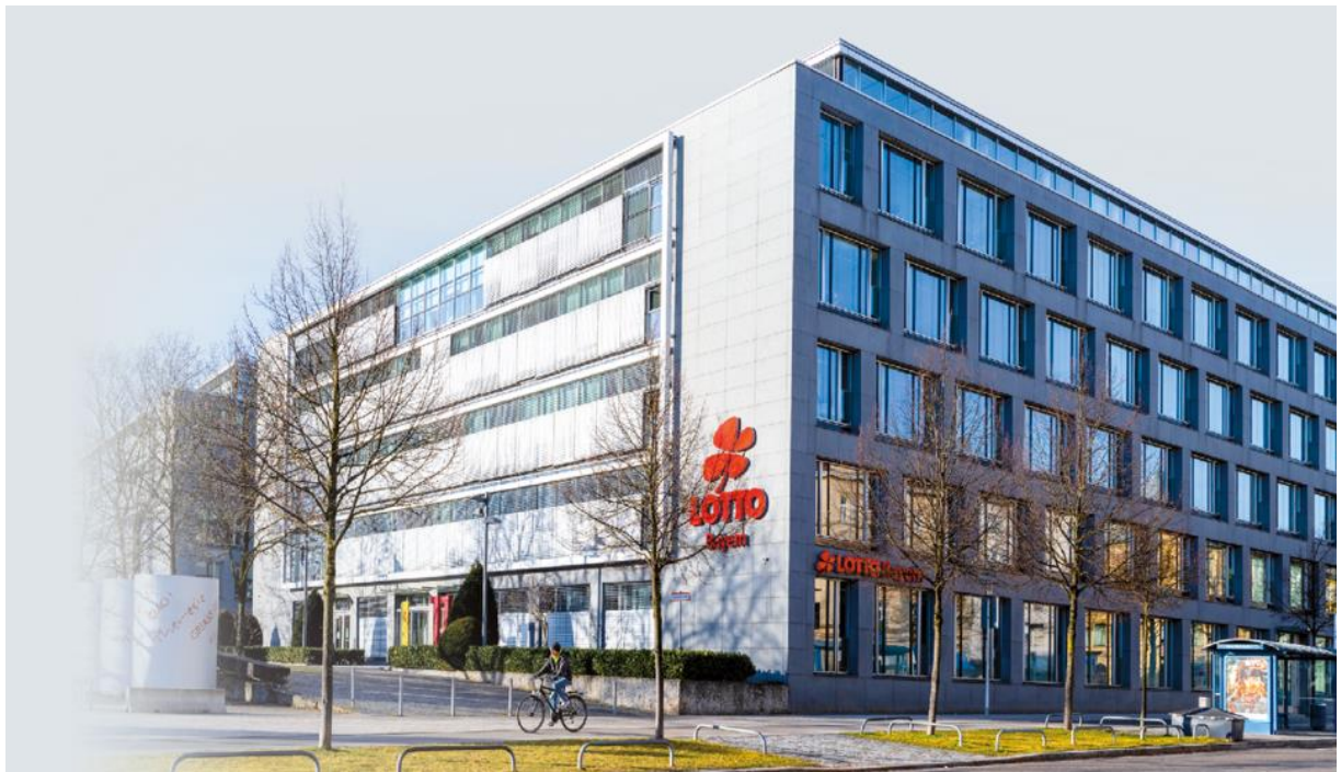
Firmenzentrale an der Theresienhöhe seit 2014
